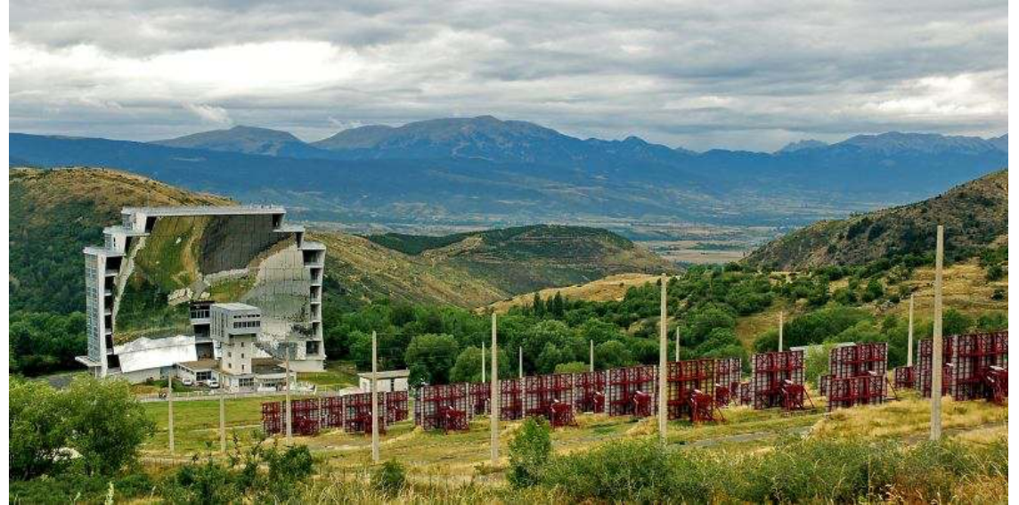
Four solaire d'Odeillo (Pyrénées) : jusqu'à 4000° C au foyer !
