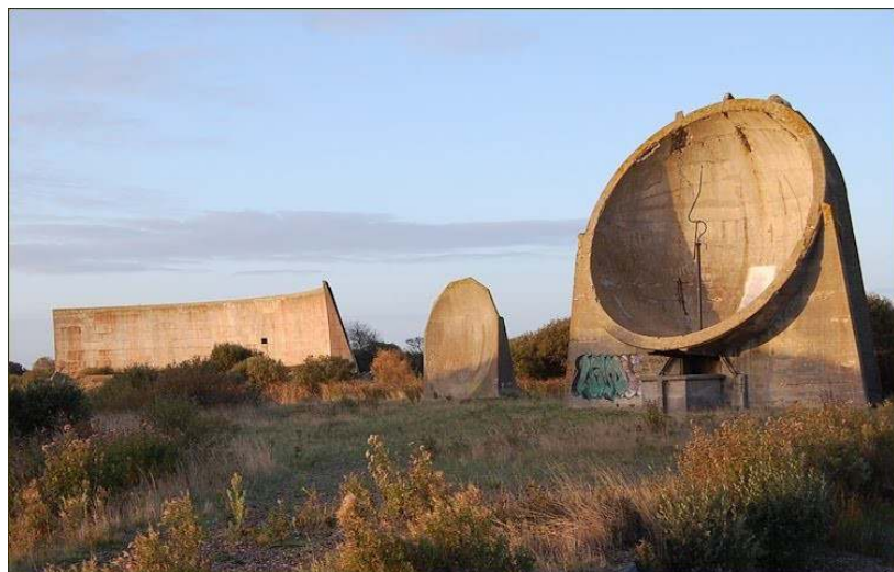
Paraboles acoustiques en béton de Denge, sur les côtes anglaises, utilisées pour la défense aérienne en 1917
